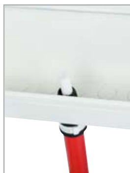
Työnnä PEX-putki kaapin sisälle.
