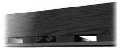
Esimerkki putkien sijoittamisesta katon harvalaudoitukseen.
