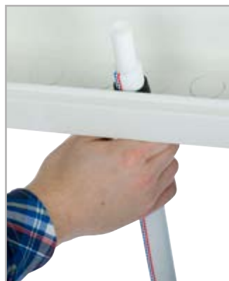
Työnnä suojaputki ja PEX-putki holkin läpi.
